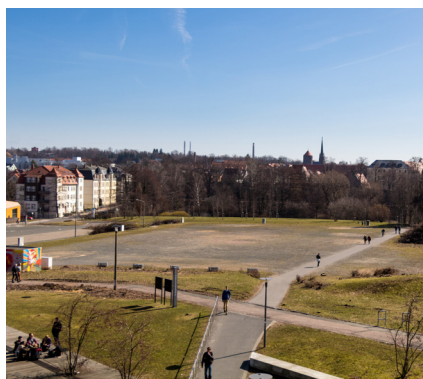
Abb. 4: Im März 2017 wurde bereits mit den Vorbereitungen des Baufeldes für das ZeHS begonnen. Quelle: Sven Jachalke
