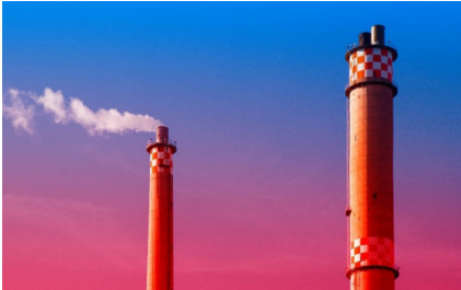
Abb. 1: Rauchgasanlagen Quelle: Sven Jachalke
